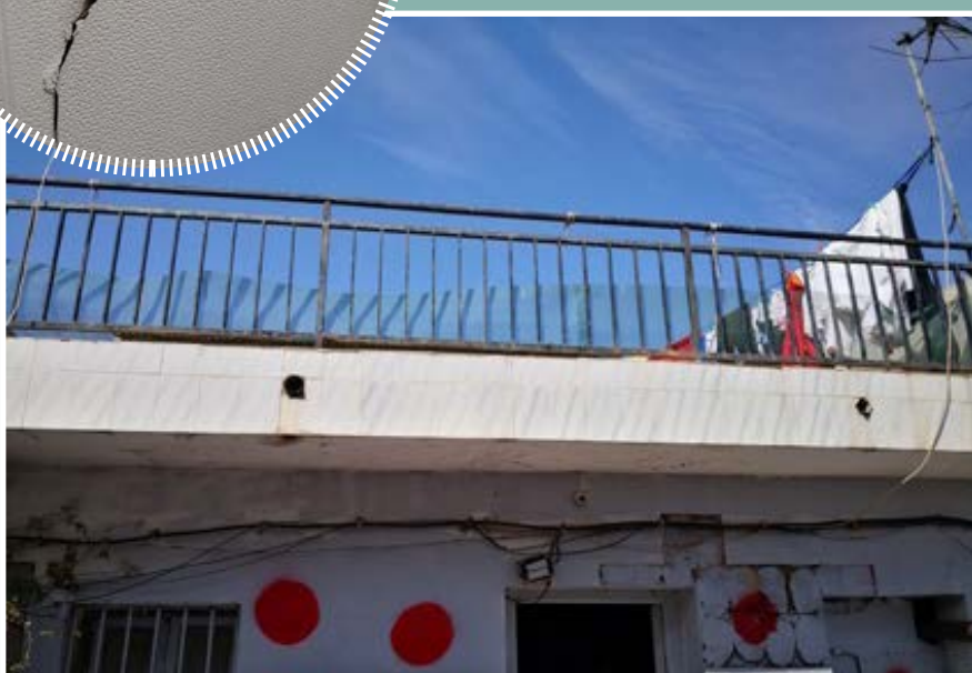
Detalle fachada y cubierta compuesta por terraza transitable
