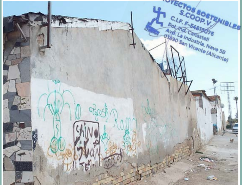
Fachada en fábrica de ladrillo muy deteriorado en la base. Remates precarios de lámina impermeabilizante sobre tejado.
