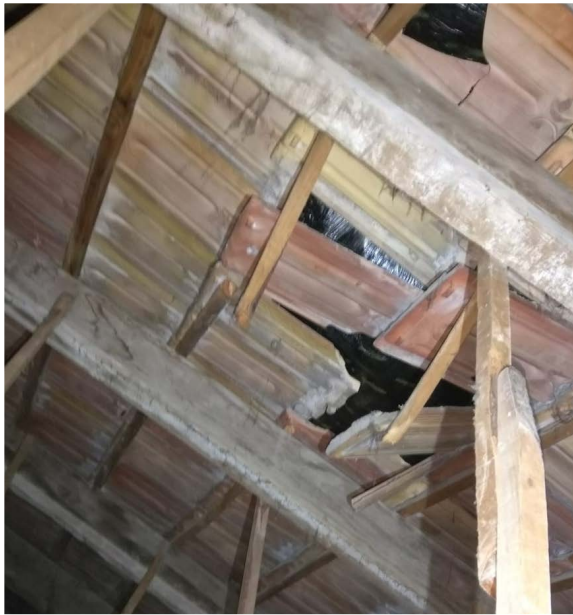
Tejas y listones rotos, estructura de viguetas de madera. Lámina bituminosa sobre la teja.
