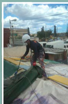
Retirada de capas en cubierta
