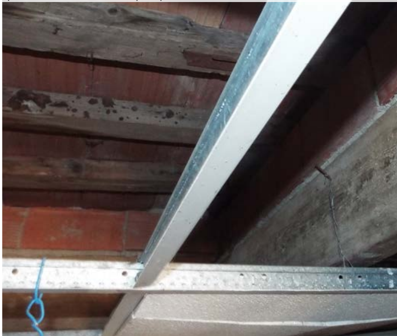
Falso techo de escayola abierto, estructura de cubierta-terracea plana terminada con plaquetas de material cerámico
