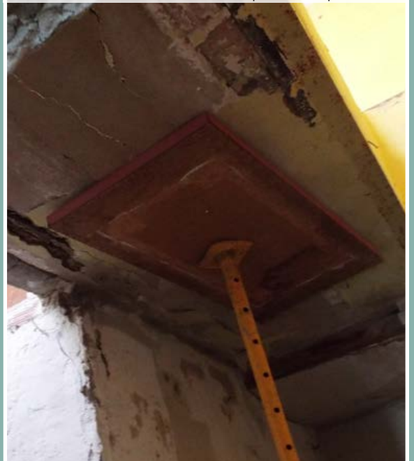
Detalle apuntalamiento existente en forjado de rellano escalera acceso a planta superior
