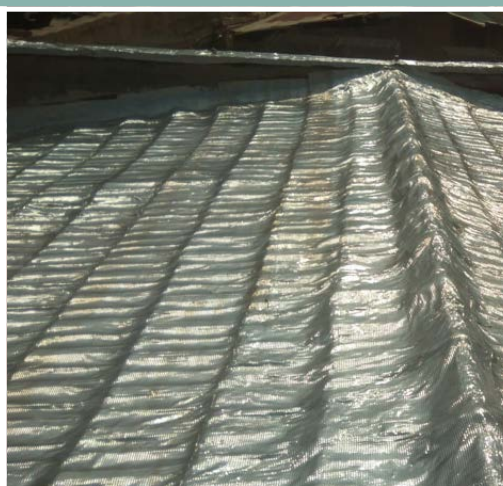
Terminaciones con pintura de caucho y lámina asfáltica
