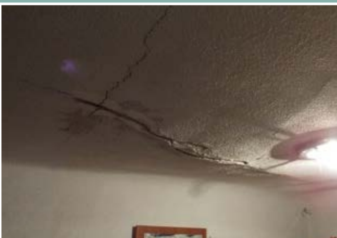
Falso techo de caño desprendido
