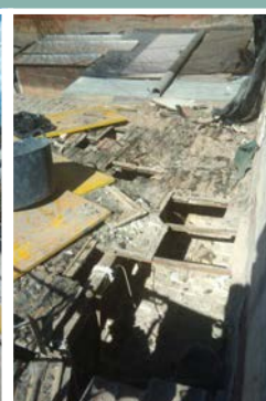
Retirada de capas en cubierta
